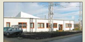
Eintritt in WiMos Firmengelände ist jetzt über das Internet möglich.
