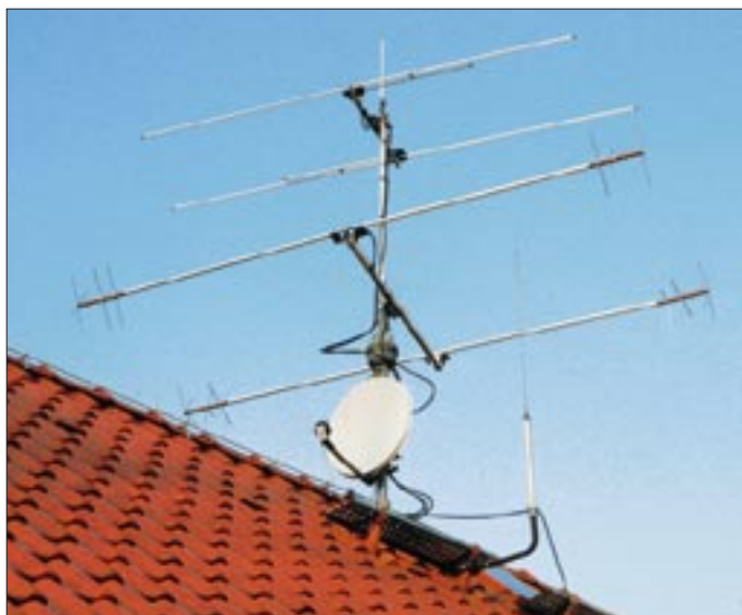
Bild 1: Miniantenne in etwa 2 m Höhe über dem Dach. Darüber befinden sich noch eine HB9CV für 6 m und ein VHF-/UHF-Rundstrahler.
